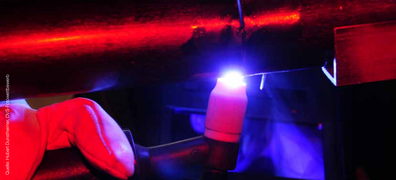
Rohrverbindung mit WIG-Schweißen.
